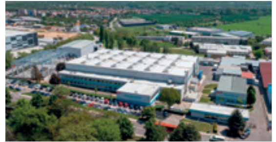
Zakład produkcyjny i centrum logistyczne w Znojmo (Czechy)
