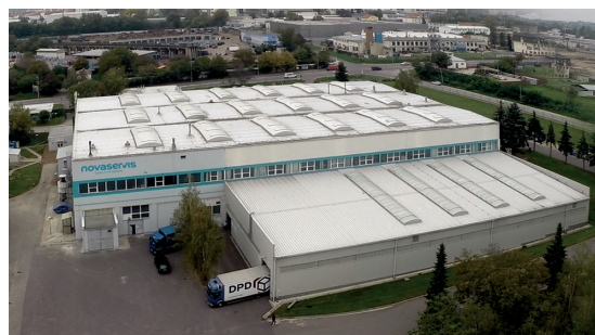
Zakład produkcyjny i centrum logistyczne w Znojmo (Czechy)
