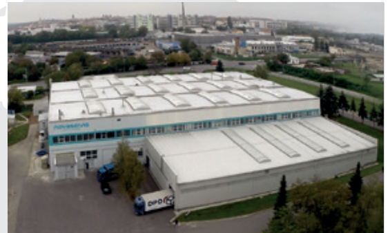
Zakład produkcyjny i centrum logistyczne w Znojmo (Czechy)
